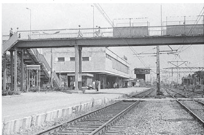
Widok z peronu na dworzec, nową kładkę stalowo-betonową oraz nastawnię – 1984 r.
