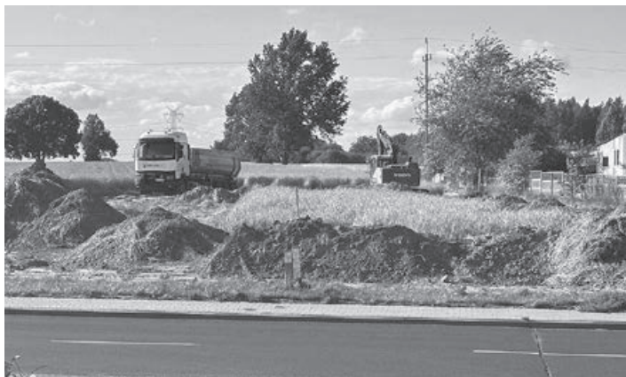
W Różycy przy ul. Zagajnikowej rozpoczęła się budowa marketu sieci DINO. To już trzeci obiekt w naszej gminie, po Koluszkach i Gałkowie Dużym.
