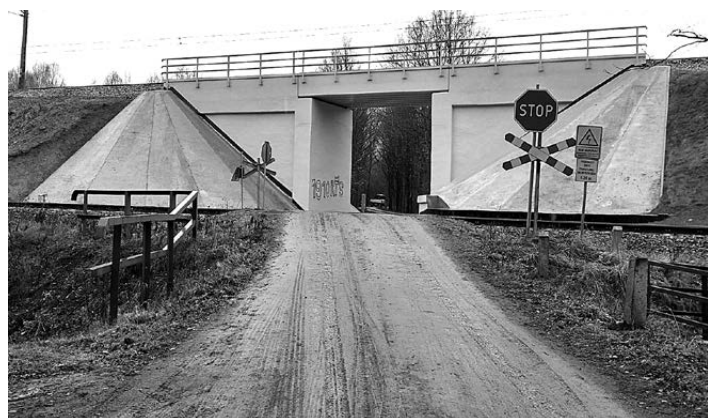
Tak prezentuje się wyremontowany przez PKP most kolejowy, który przechodzi nad tzw. „czarną drogą” z Koluszek do Będzelina.
