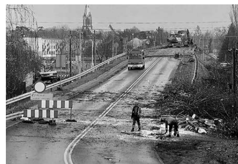
Część wiaduktu od strony bloków została już usunięta aż do nasypu. Obecnie demontowany jest fragment pod którym odbywa się ruch pociągów.
