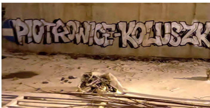
Budowa wiaduktu w Koluszkach. Jeszcze nieukończony, a już z autografem.
