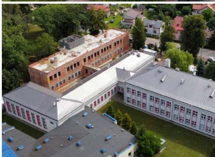
Widok na powstające nowe skrzydło szkoły pod potrzeby SP nr 2 i LO w Koluszkach. Obiekt ma powstać do końca roku.
