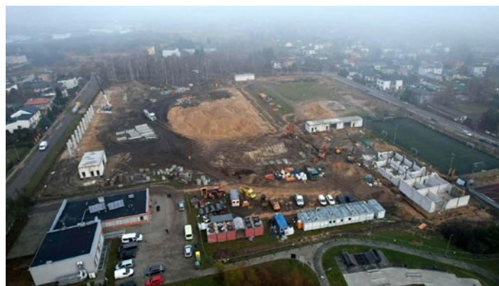
Plac budowy – zdjęcie z połowy grudnia
