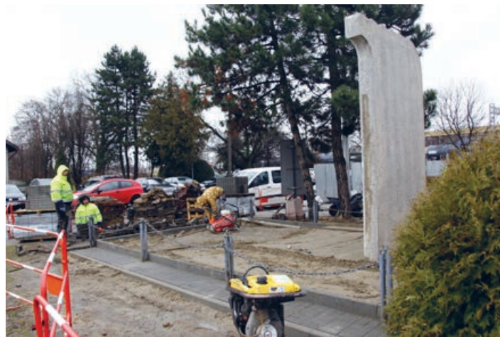
Remontowany pomnik ofiar okupacji niemieckiej
