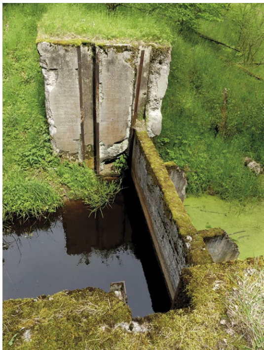
Dolina Pastęki – jaz betonowy
